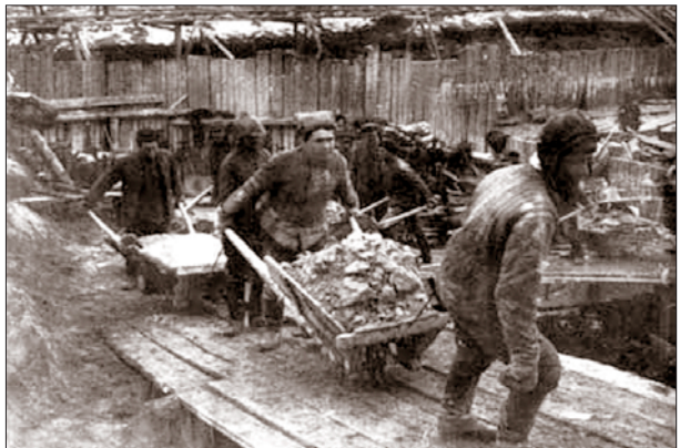
Ryc. 3. Więźniowie przy budowie Kanału Białomorsko-Bałtyckiego (archiwum CILP)
