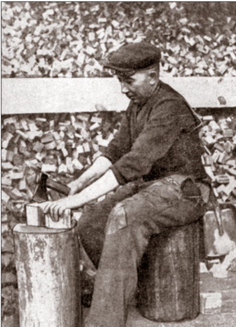
Ryc. 3. Wyróbka „zrębków” drewna generatorowego („Las i Drewno” 1942)
